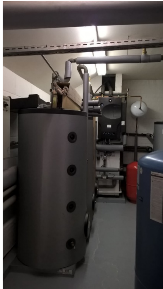
Local technique : 4 ballons de stockage de 500 litres
