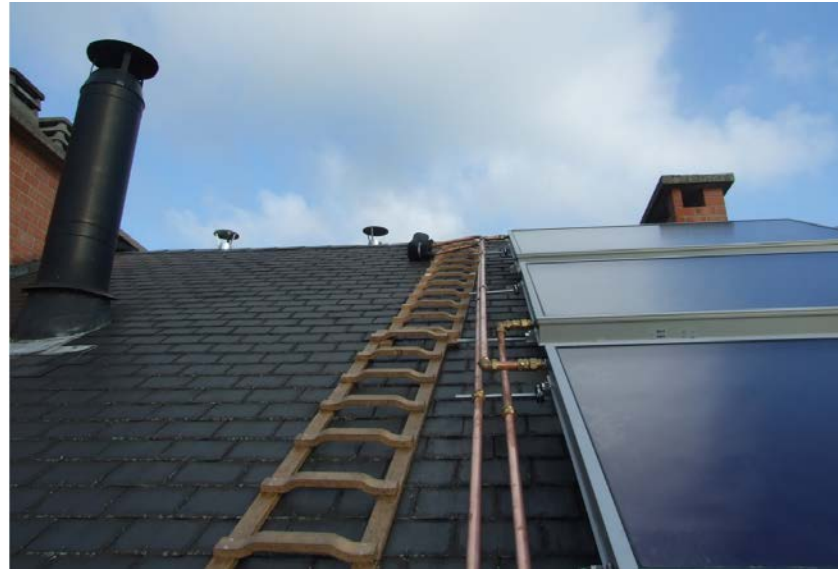
Mise en œuvre de 16 panneaux solaires thermiques
