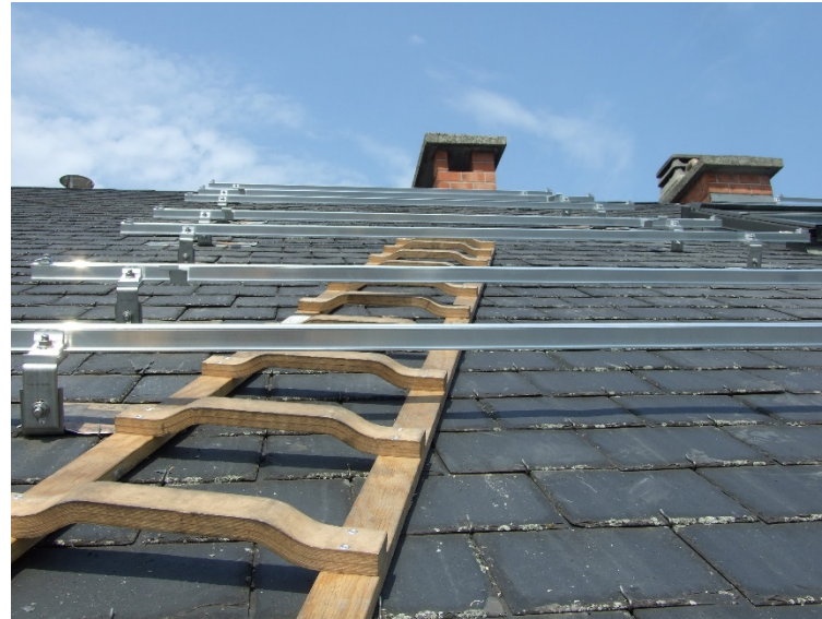
Mise en œuvre de la structure portante
