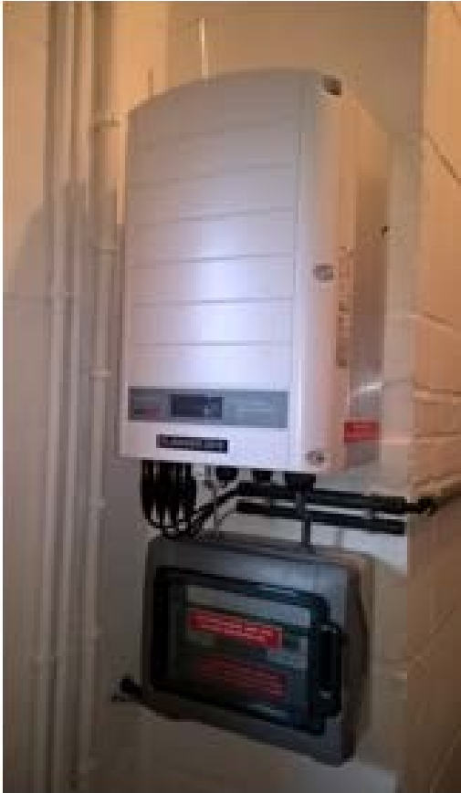
Onduleur : puissance 10 kW
