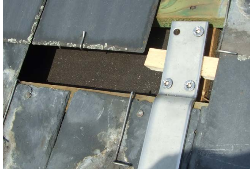
Mise en œuvre des pattes de fixation
